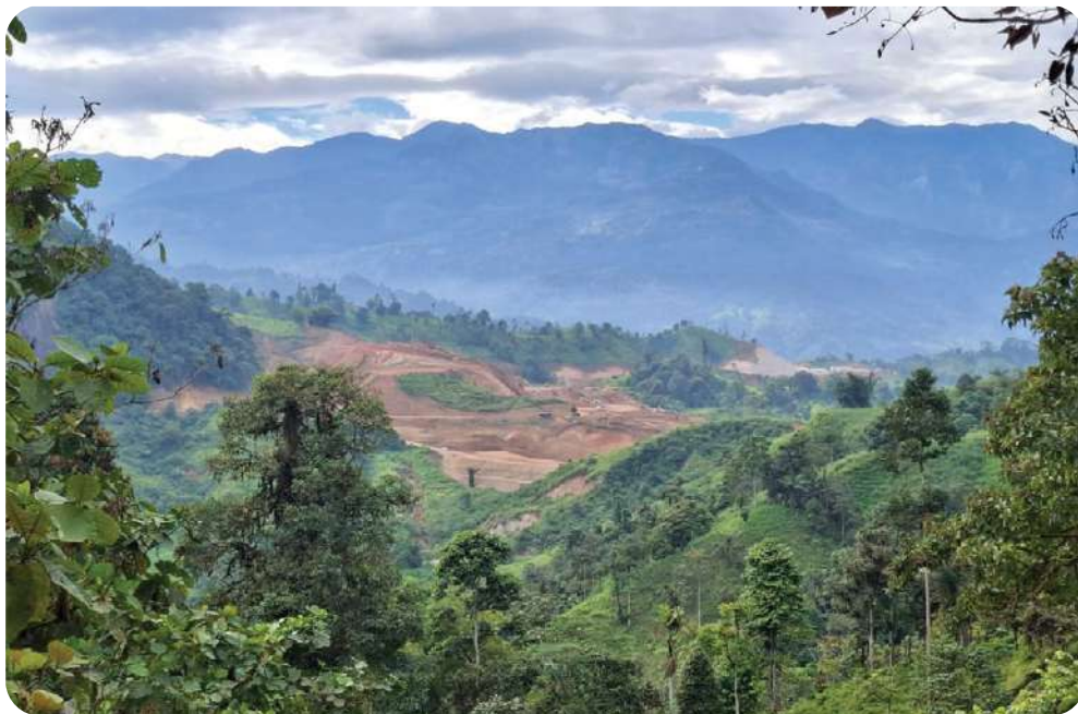
Fotografía: Sofía Carpio, 2025. Desbroce y movimiento de tierras en el cerro Piedra Negra (El Domo).
